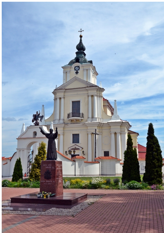
Zdjęcie nr 5. Kościół p.w. Wniebowzięcia Najświętszej Maryi Panny w Siemiatyczach (źródło: archiwum UM Siemiatycze)
